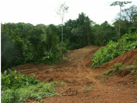
村の近くまで迫りつつある道路建設
